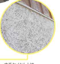
木モセメントとは... 木質原料とセメントとを混合した材料。
